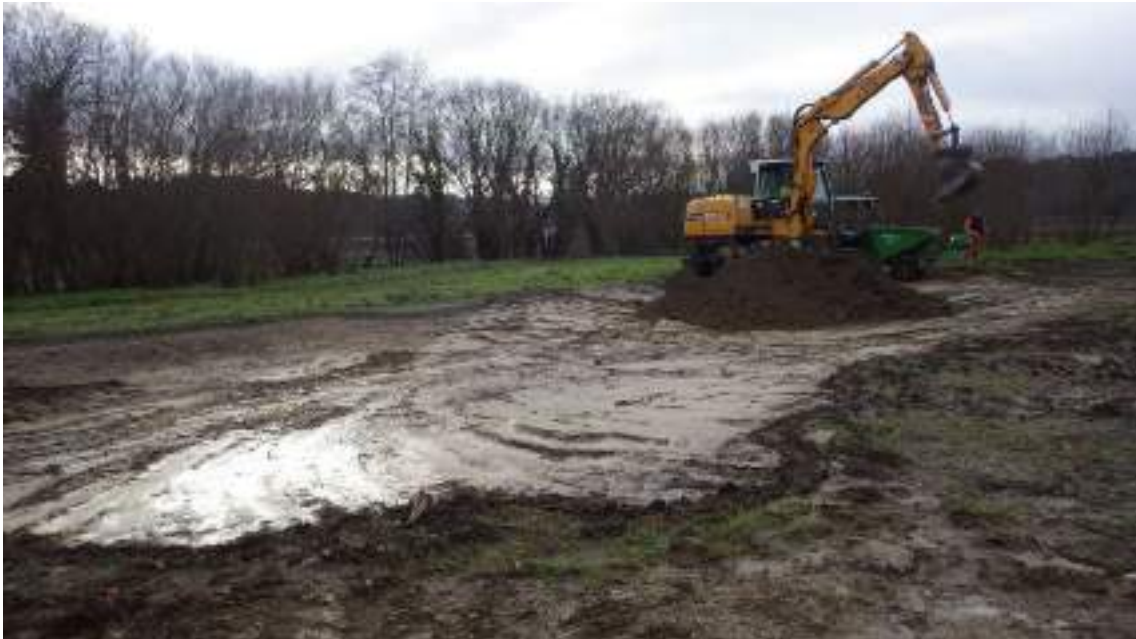
Trabajos de corrección y recuperación de la funcionalidad del espacio.
