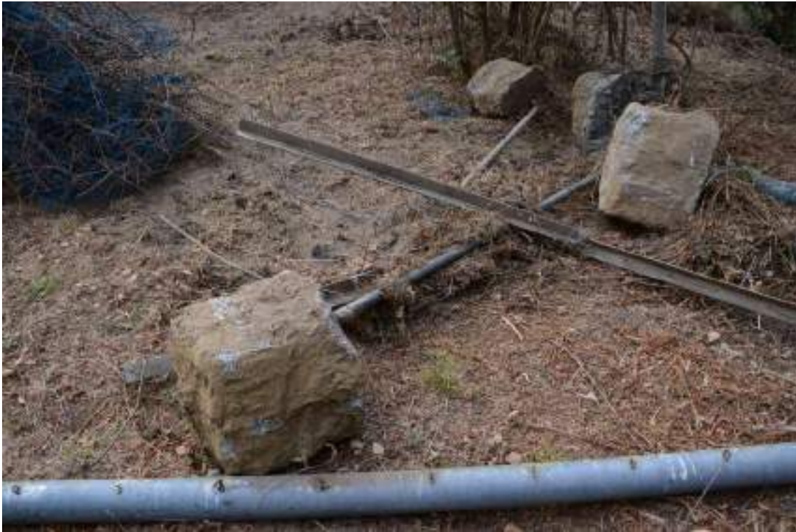
Retirada de materiales ajenos al espacio.
