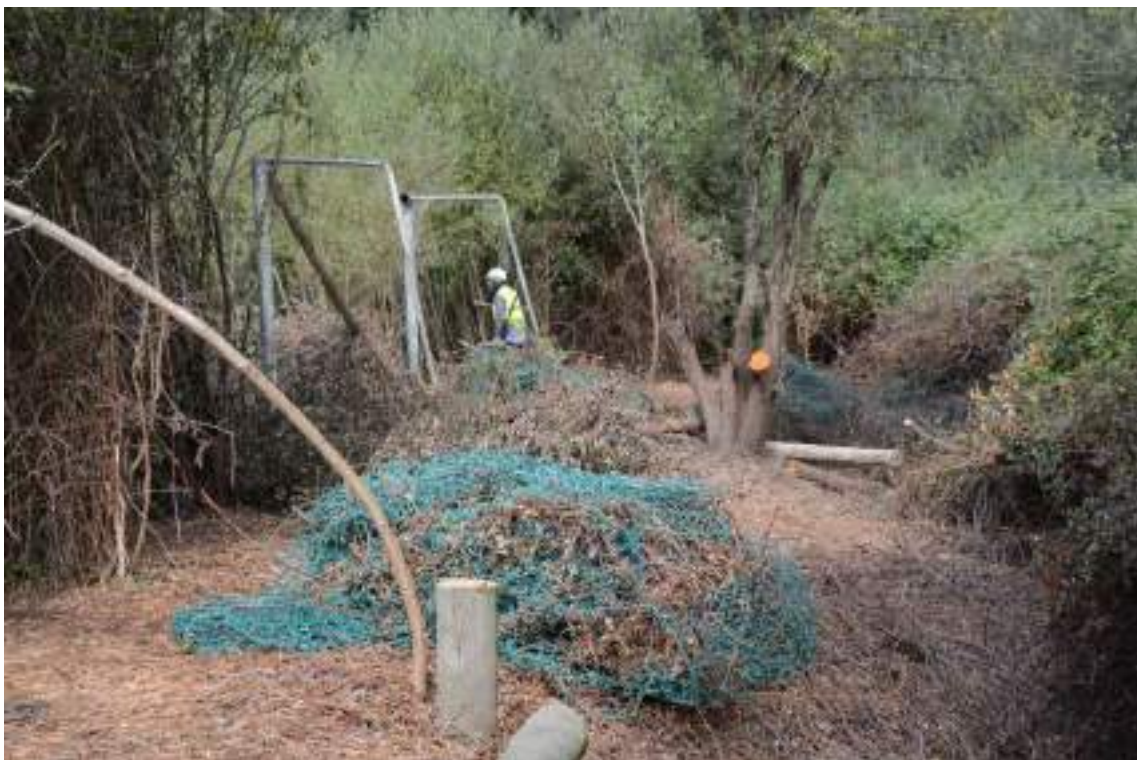
Retirada de materiales ajenos al espacio.
