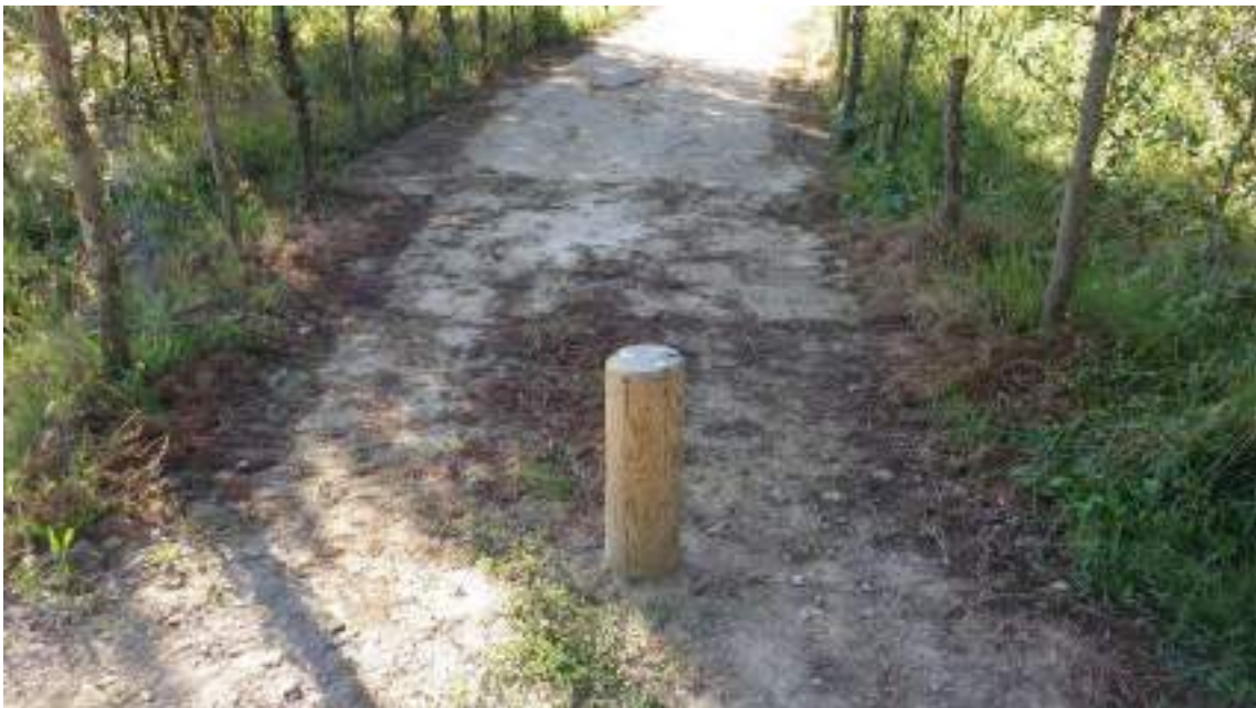
Instalación de dispositivos de control de acceso de vehículos a los senderos.
