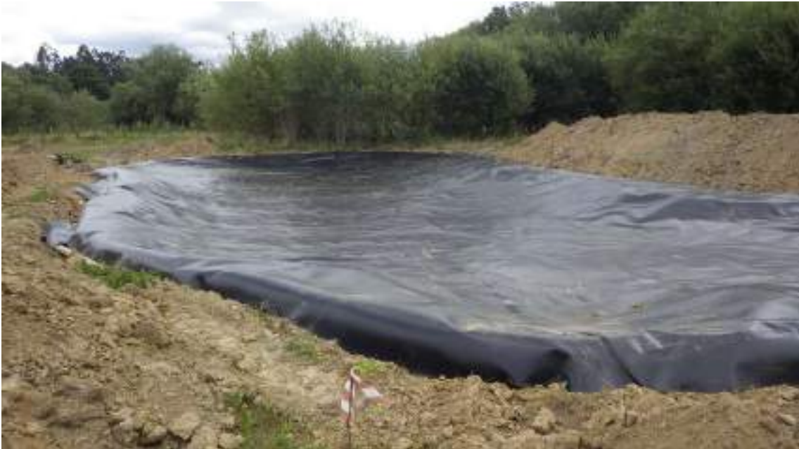
Trabajos de impermeabilización de los trabajos para la recuperación de la funcionalidad del espacio.
