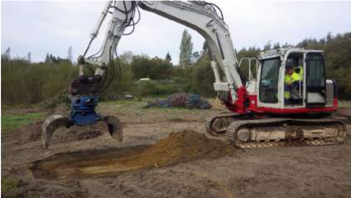
Trabajos de corrección y recuperación de la funcionalidad del espacio.
