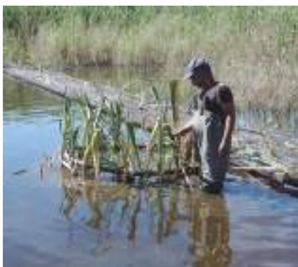
Fig. 3. Construcción en proceso de un pantano adyacente a las obras de tratamiento de aguas residuales, De Rust, Klein Karoo.
