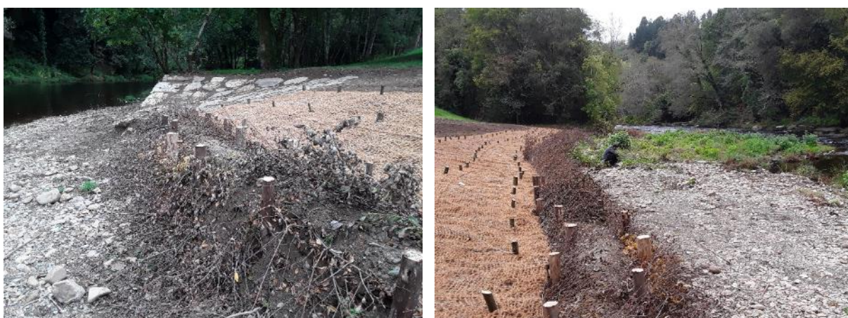
Figura 27. Parte de la obra de bioingeniería y plataforma de escollera que da acceso al río (izquierda) y vista general de la actuación una vez finalizada (derecha).
