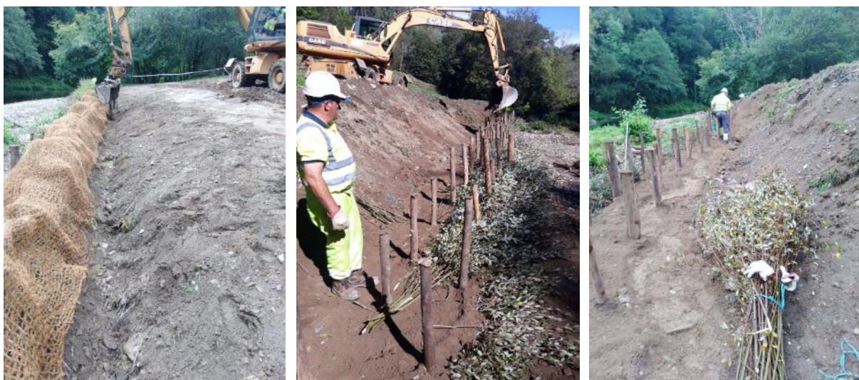
Figura 26. Operarios de Tragsa en diferentes momentos de la obra de bioingeniería.
