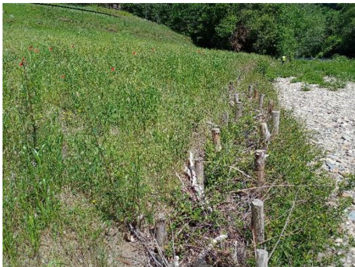
Figura 28. Aspecto general en mayo 2021 de la ribera restaurada.
