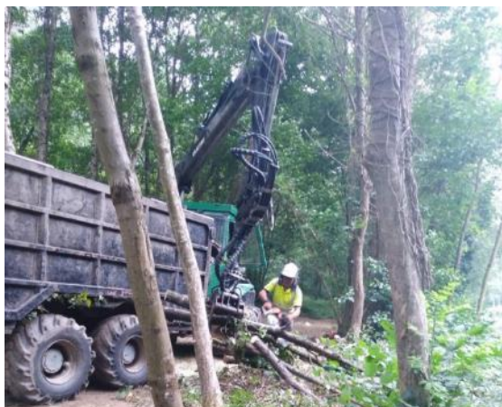
Figura 22. Operarios de Tragsa en la tala del chopo ( Populus × canadensis ) de la parte inicial del enclave de actuación.
