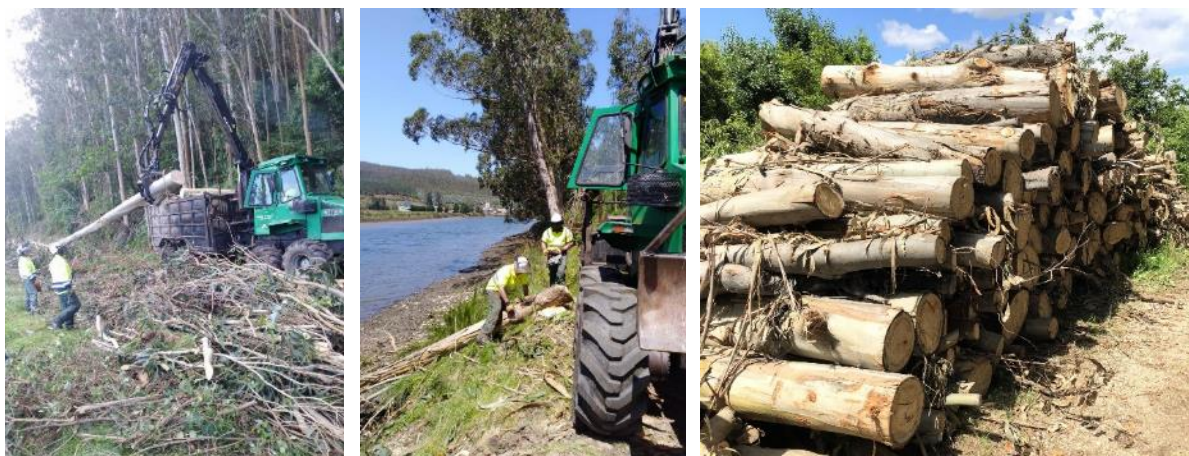
Figura 47. Diferentes momentos durante la tala de los eucaliptos (izquierda y centro) y acumulación de madera preparada para los propietarios de las fincas adyacentes a la zona de actuación (derecha).
