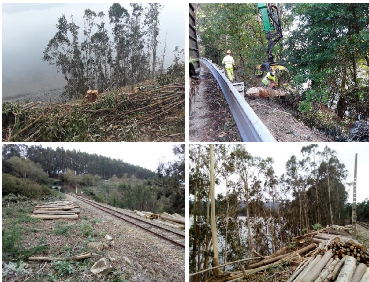
Figura 16. Diversos puntos del enclave de actuación durante la tala de los eucaliptales.
