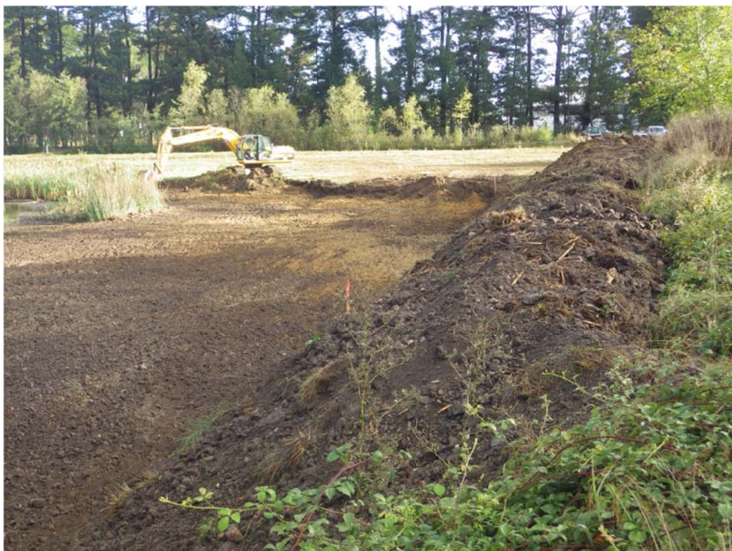
Comienzo de los trabajos de corrección topográfica del borde lacunar.
