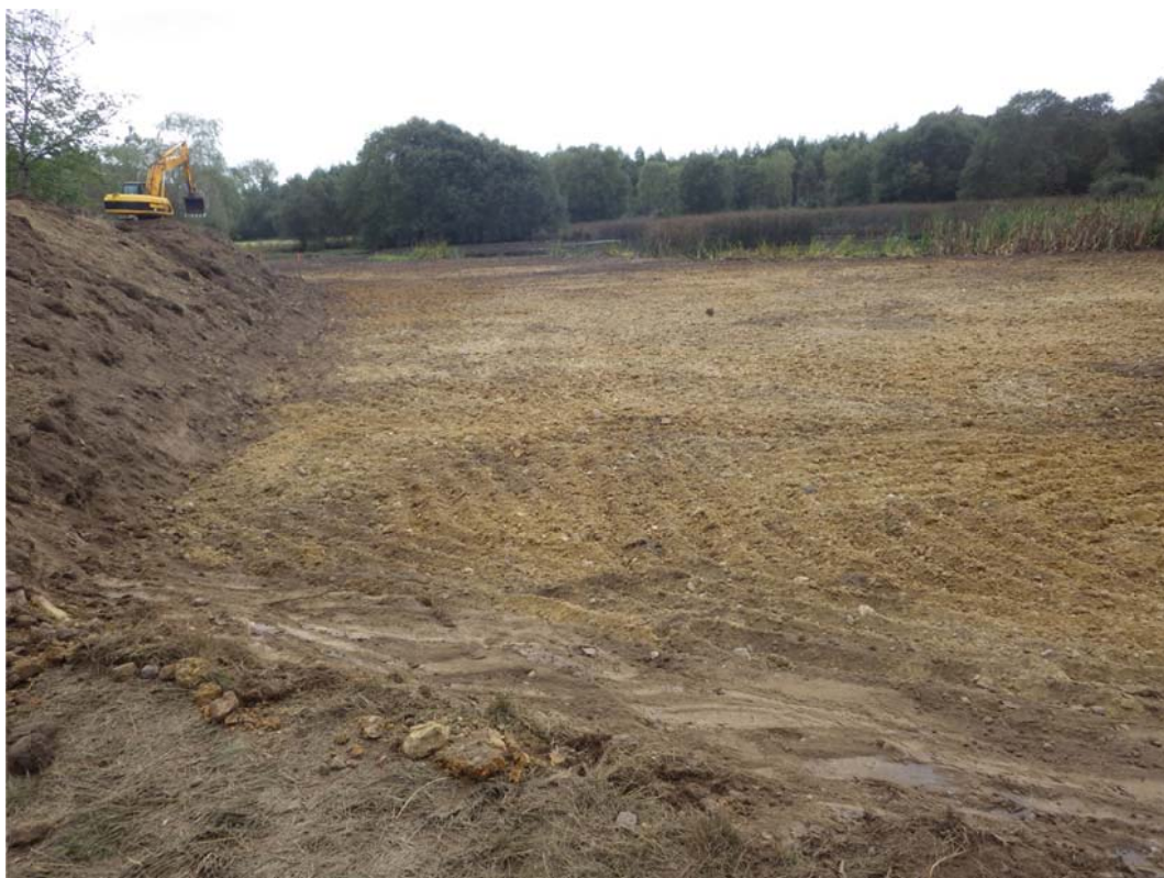
Refuerzo de la mota de protección de la laguna.
