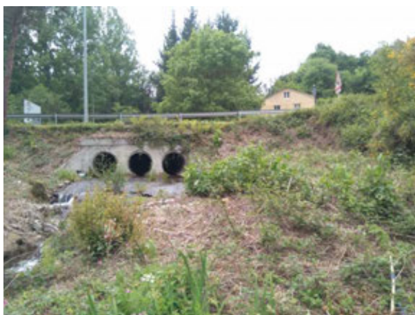
5. Salida de la entubación bajo la carretera de arroyo lateral.
