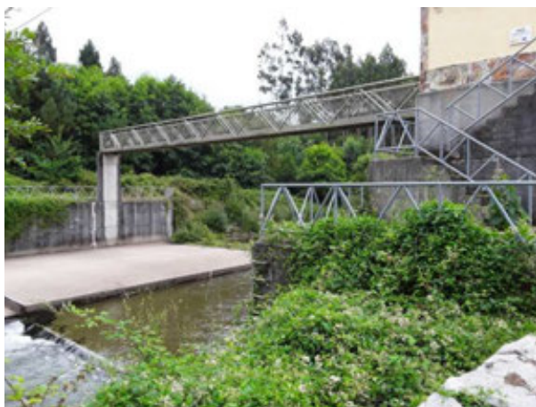
3. Estación SAIH, con losa de hormigón en el lecho, pasarela y canalización de hormigón y escollera.
