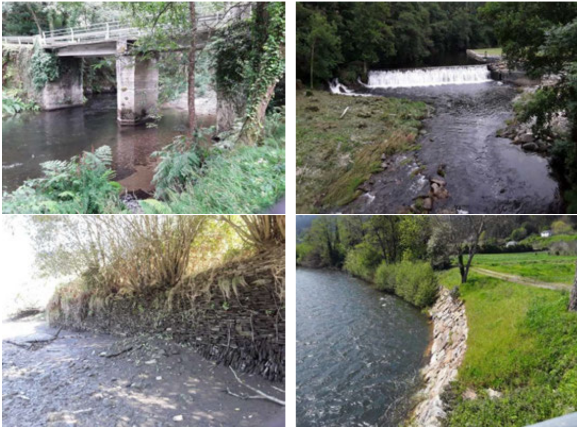
Figura 12. Diferentes tipos de estructuras artificiales cartografiadas: puente (arriba izquierda), azud (arriba derecha), muro de mampostería (abajo izquierda) y escollera (abajo derecha).
