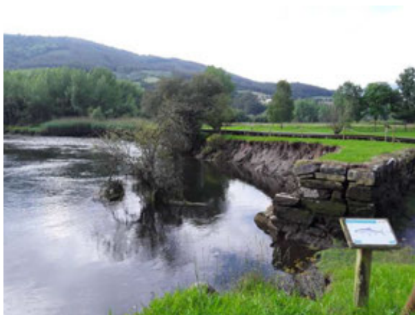
3. Estado de la orilla y de la escollera afectadas por la erosión.
