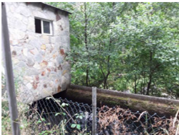
4. Central hidroeléctrica con muro de hormigón separando el canal de derivación del canal principal.
