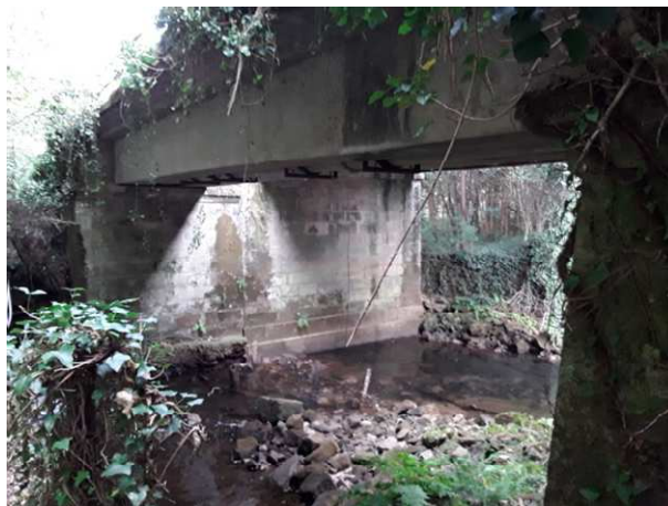
2. Puente sobre el río Estorãos.
